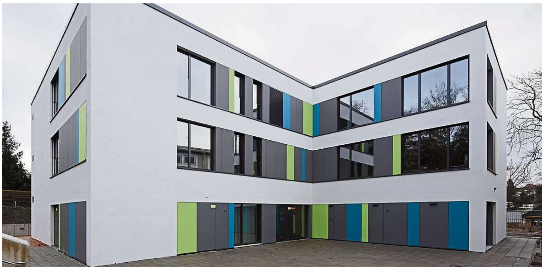
Seit vergangenem Jahr hat die Johannes-Maaß-Schule einen Neubau. Doch um auf den Schulhof zu gelangen, müssen die Kinder noch immer den dahinterliegenden maroden Altbau durchqueren, in dem einige Bauteile als Sicherheitsmaßnahme abgestützt wurden. Archivfoto: Thomas Eicken
